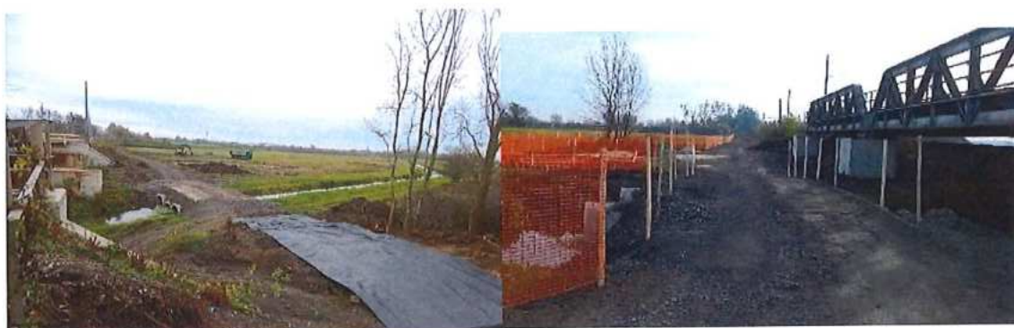
b) Výkopy bez zaistenia stien a zabezpečenia proti pádu
