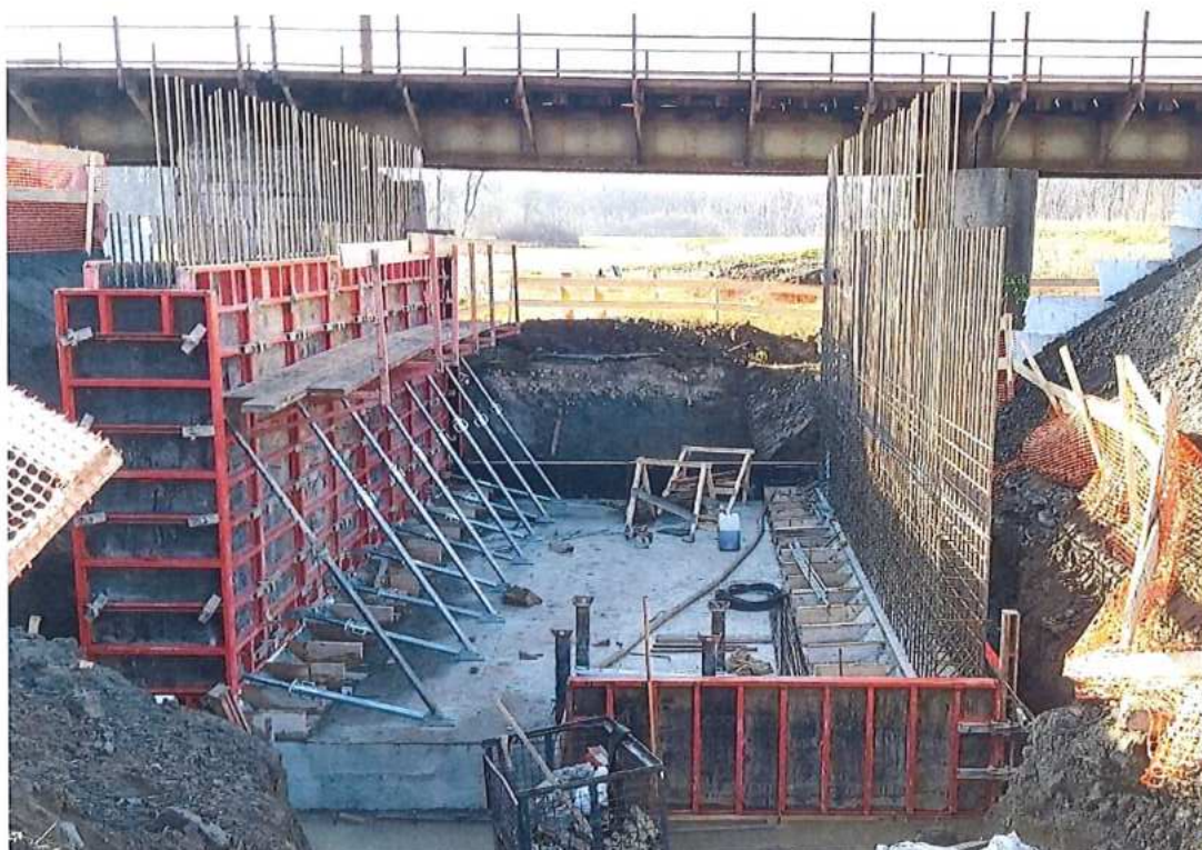
Zabetónovanie bočnej steny priepustu SO 12-33-03
