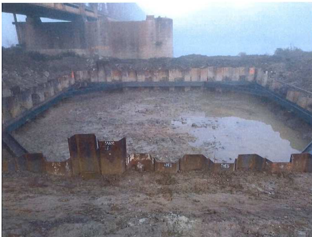
Zriadenie rozperného rámu pre výkop základov piliera č. 1
