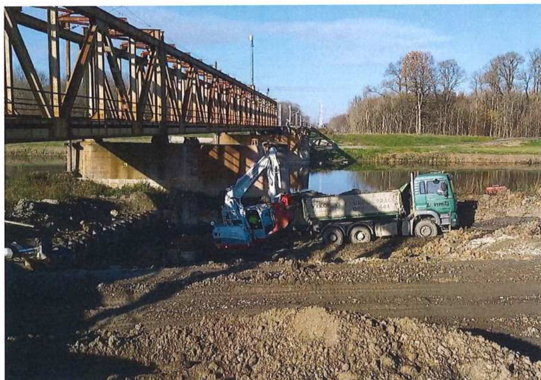
Výkop základu pre pilier P1 (na strane SK) SO 12-33-04
