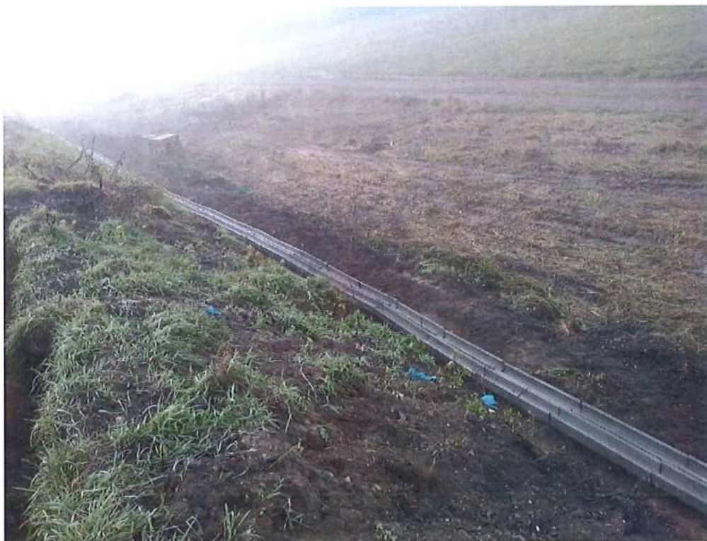
Príprava káblovej chráničky pri koľaji číslo 1 od „S“ prepojenia po most 74,386
